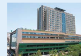
帝京大学医学部附属病院(板橋区)
